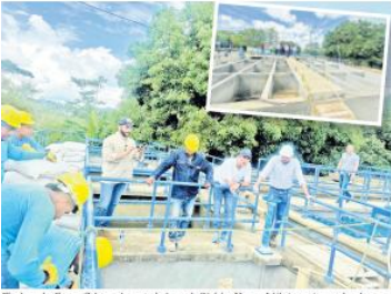
El gobernador Erasmo Zúñiga y el gerente de Agua de Córdoba, Marlen Jaldú, inspeccionan las obras en el Acueducto de El Porvenir.
